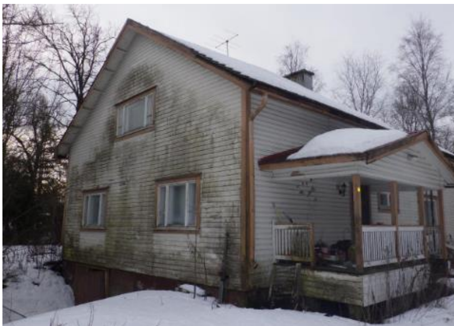
Kuva: Tontilla sijaitsevassa rakennuksessa on suoritettu kosteus- ja sisäilmatekninen kuntotutkimus (Raksystems, 2021).
